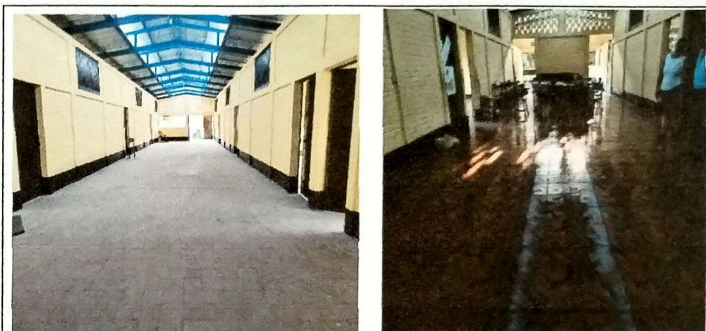
Foto 2: MODULO B corredor principal se instalo piso ceramico.
