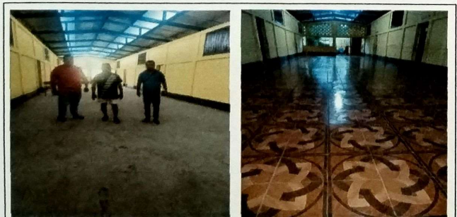
Foto 5: MODULO B corredor principal se instalo piso ceramico.
